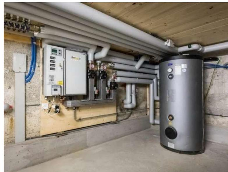
Abb. 33: Fernwärmeübergabestation mit gedämmten Leitungen und Warmwasserspeicher
