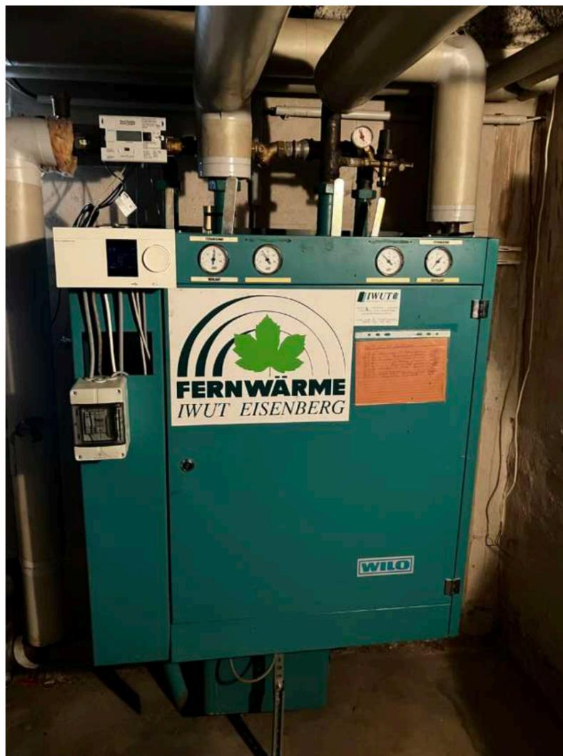
Abb. 23: Fernwärmeübergabestation der IWUT Eisenberg
