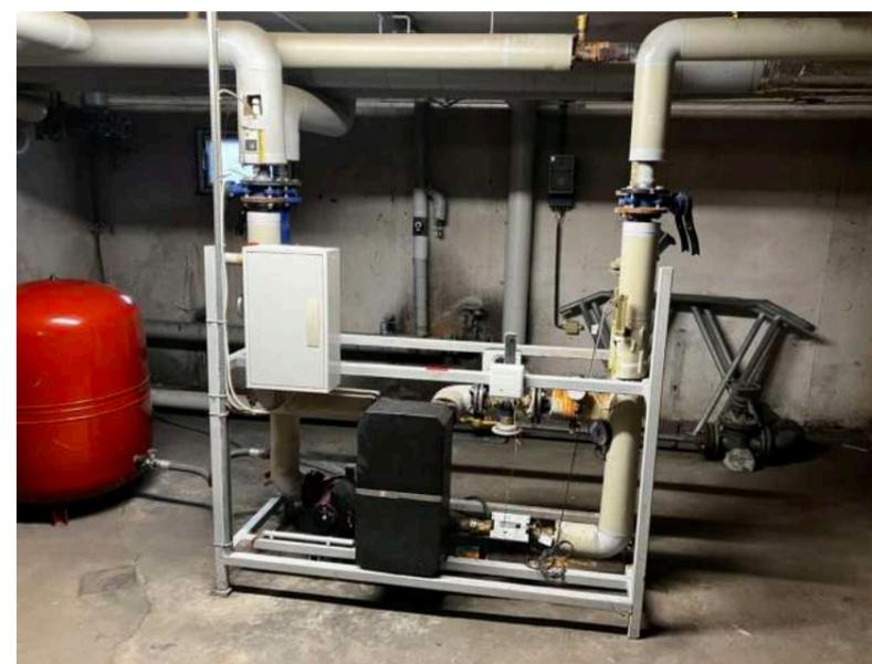
Abb. 26: Mangelhafte Wärmedämmung und bereits erste Korrosionserscheinungen an bestehenden Leitungen
