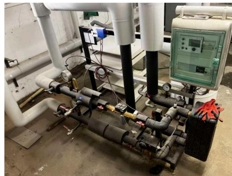
Abb. 25: Nachgerüstete Leitungen mit fernablesbarem Wärmemengenzähler und fernsteuerbarer Regelungstechnik mit BUS-Schnittstellen
