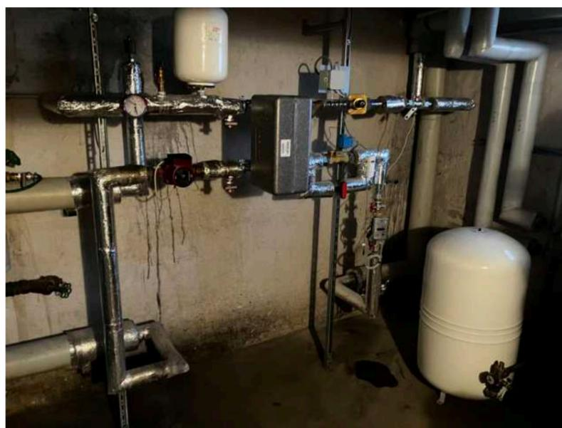
Abb. 24: Wärmetauscher mit tropfenden und nicht ausreichend gedämmten Leitungen
